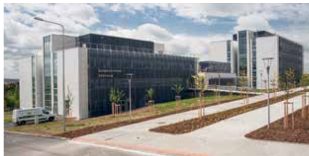
Dokončená I. etapa v roce 2014
