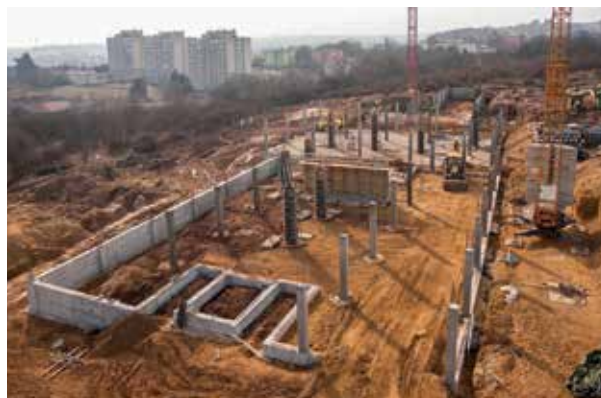
I. etapa výstavby – základy Biomedicínského centra a budovy teoretických ústavů
