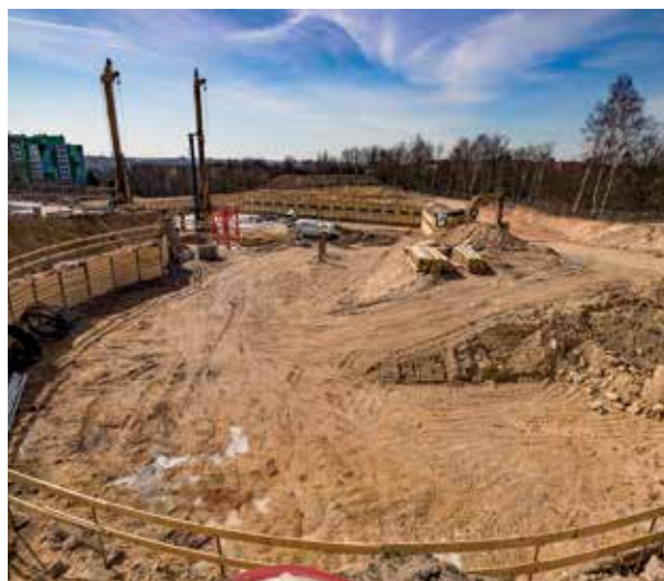
Stavební jáma na začátku roku 2020
